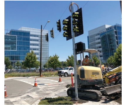
▲ New signal installation at Bordeaux Drive and Innovation Way Instalación de nuevos semáforos en Bordeaux Dr e Innovation Way 在 Bordeaux Drive 和 Innovation Way 路口安裝新號誌燈
