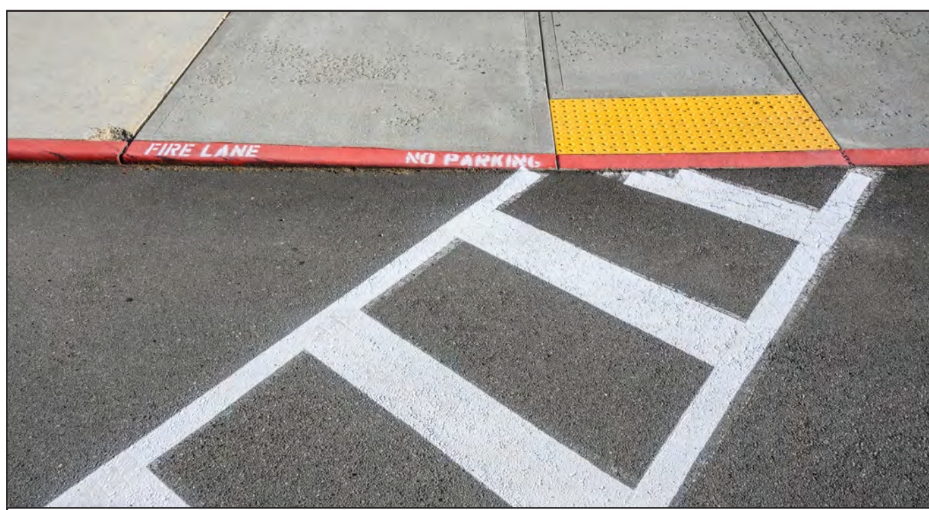
Curb Ramps/ADA Accessibility 路緣坡道/無障礙設施
